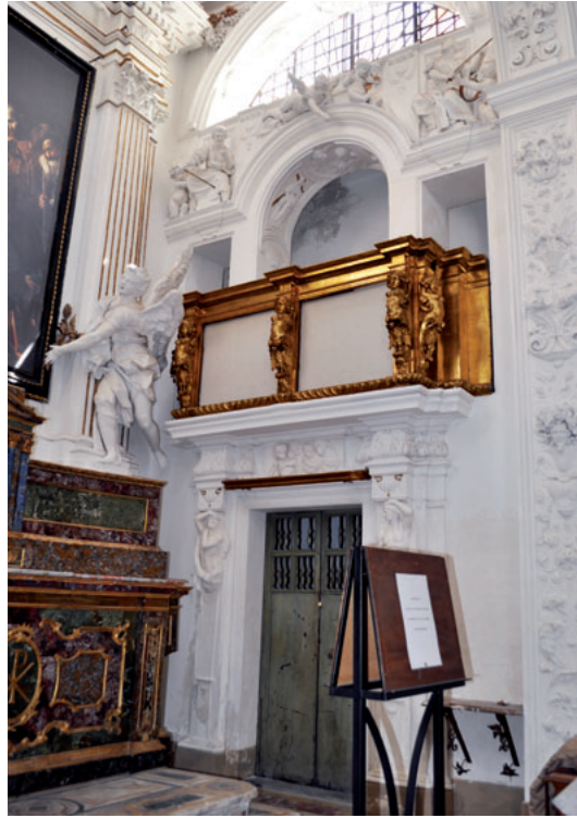
26. Particolare della controfacciata.
