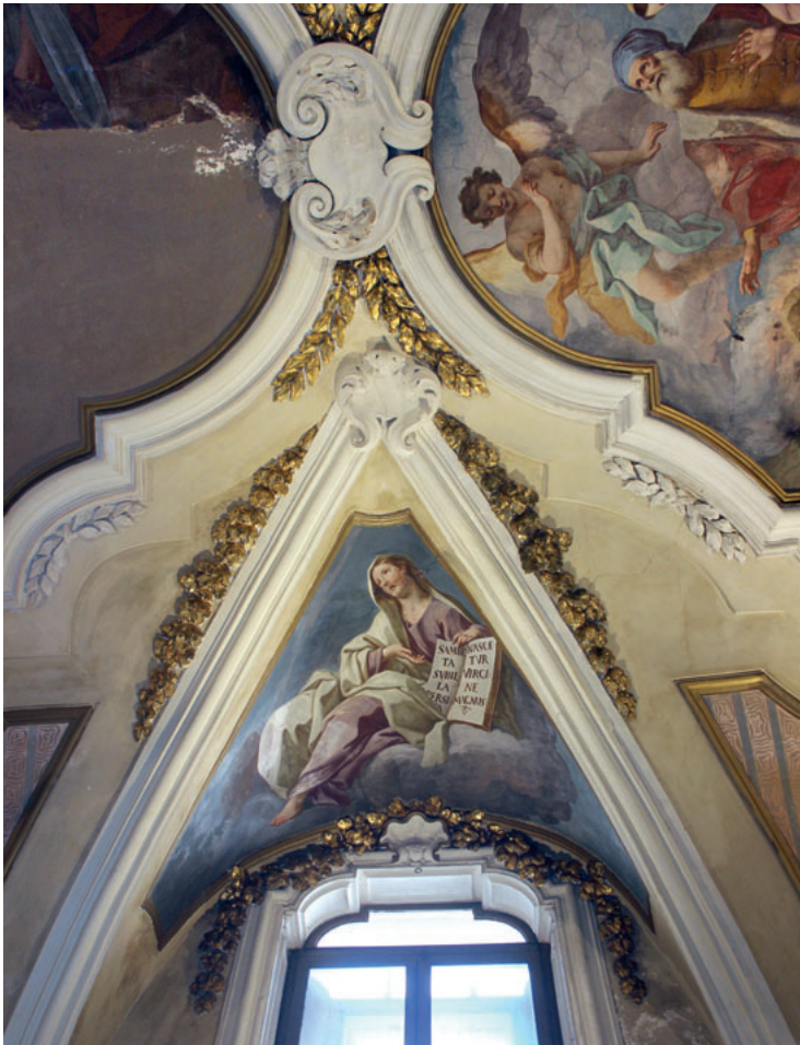
1. Particolare della volta.
