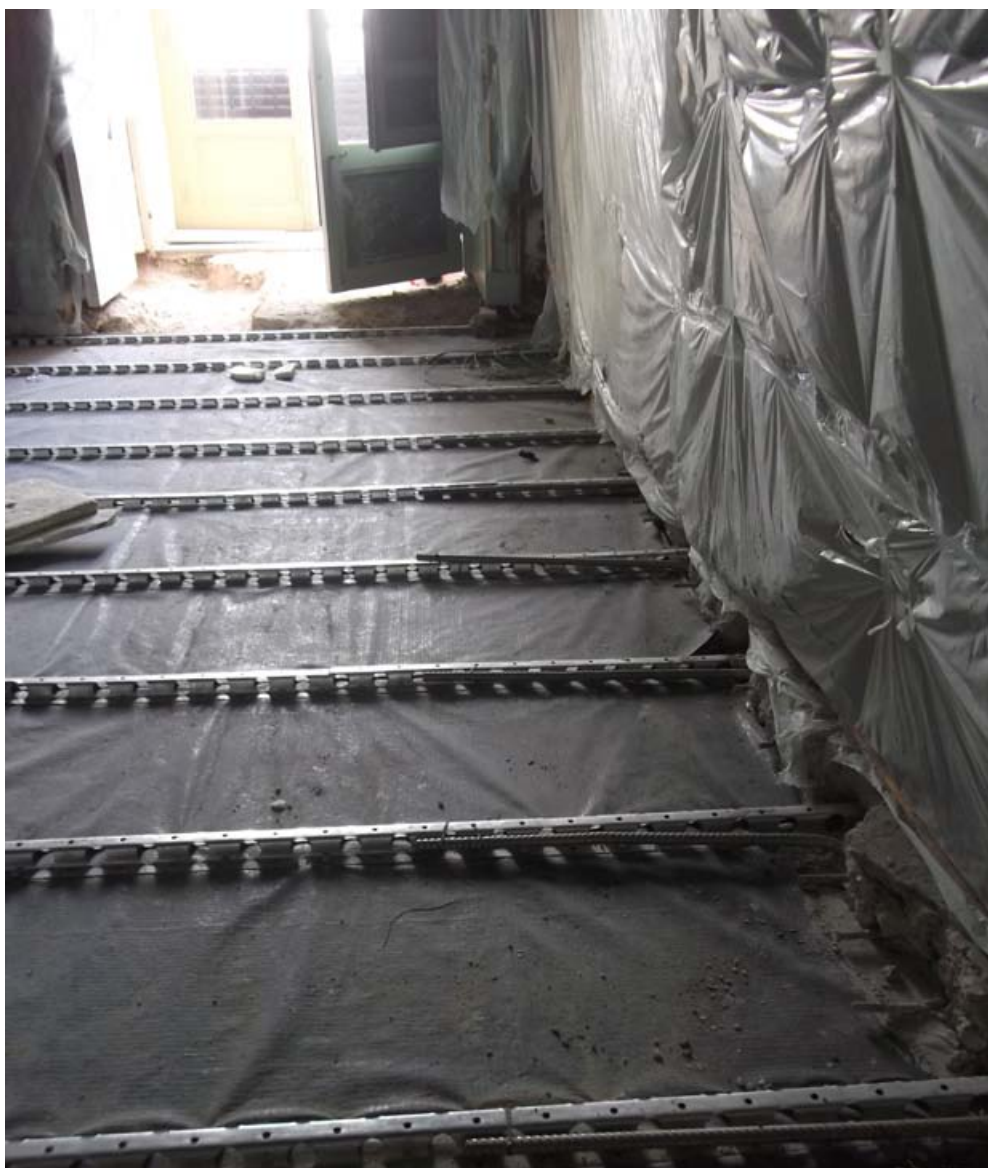
Sala pompeiana - Consolidamento con sistema a traliccio
