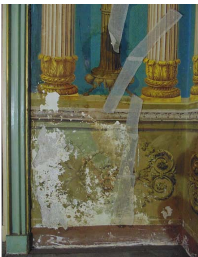
Particolare lambris con disgregazione del colore
