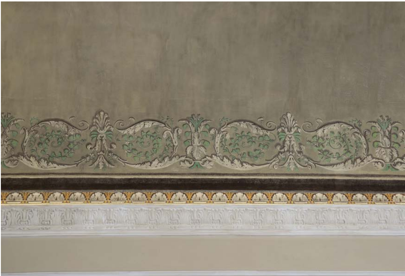
Particolare del cornicione e del decoro dopo il restauro
