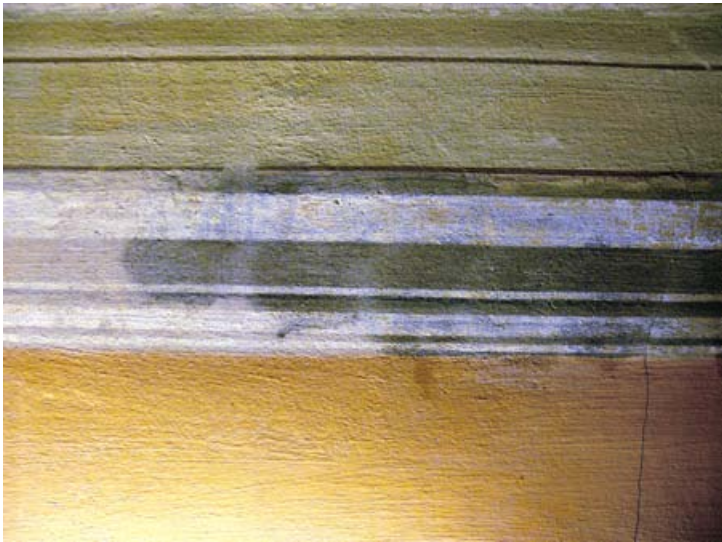
Particolare finto cornicione
