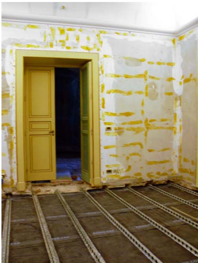
Sala Savoia - Solaio esistente
