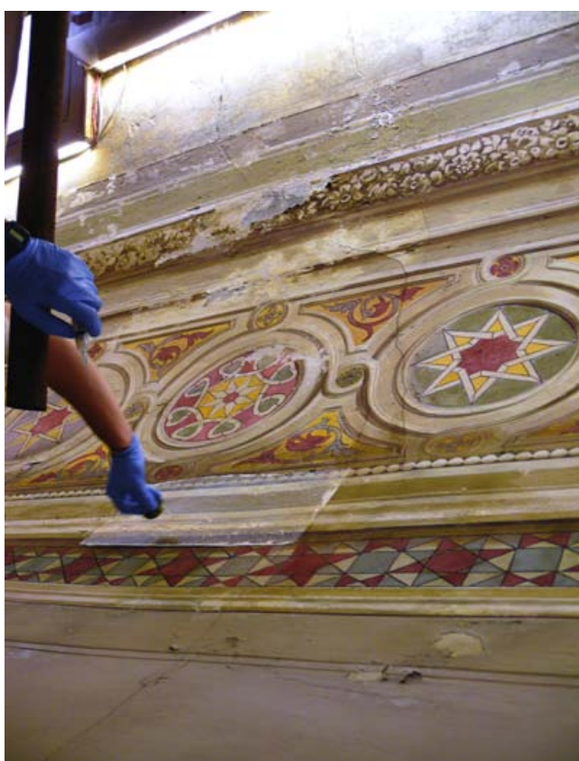
Rimozione delle efflorescenze saline.
