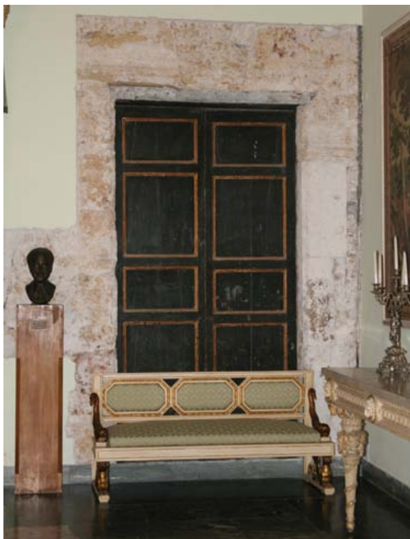
Particolare porta e parete del fronte normanno
