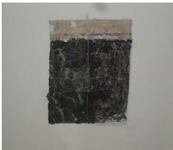
Particolare del saggio sulla parete
