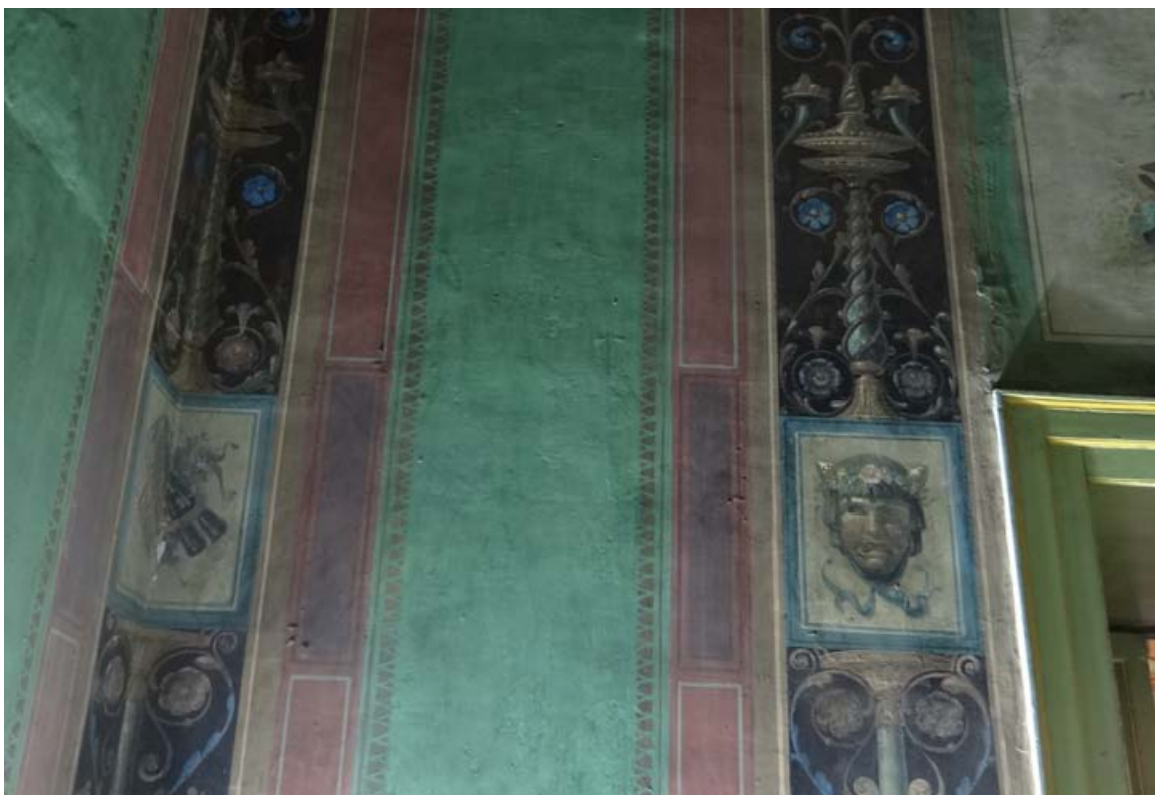
Particolare parete con evidenti strati di pittura sovrapposti
