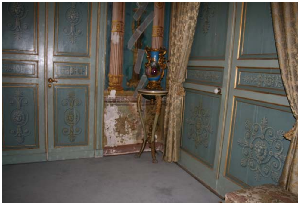
Particolare porte prima dell'intervento di restauro
