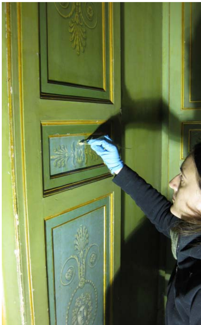
Rimozione delle ridipinture
