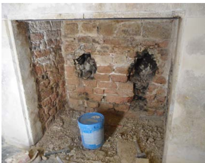
Il camino prima e dopo l'intervento
