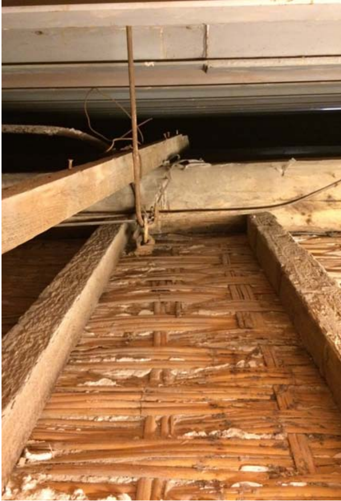
Particolare dell'estradosso della volta incannucciata
