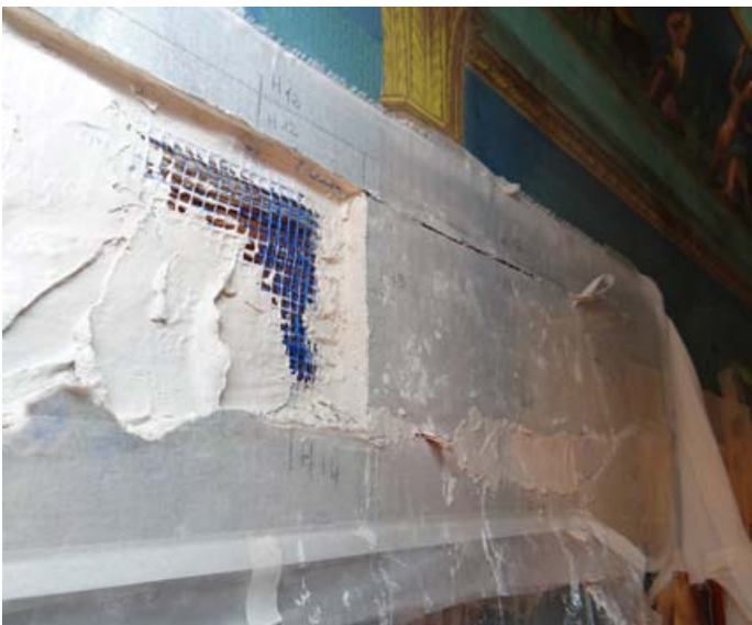
Fasi di stacco e ricollocazione di intonaco dipinto
