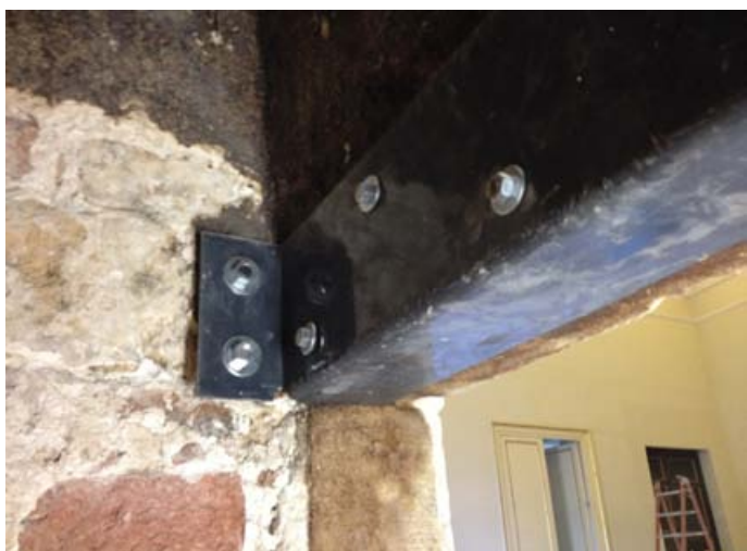
Particolare del consolidamento del camino
