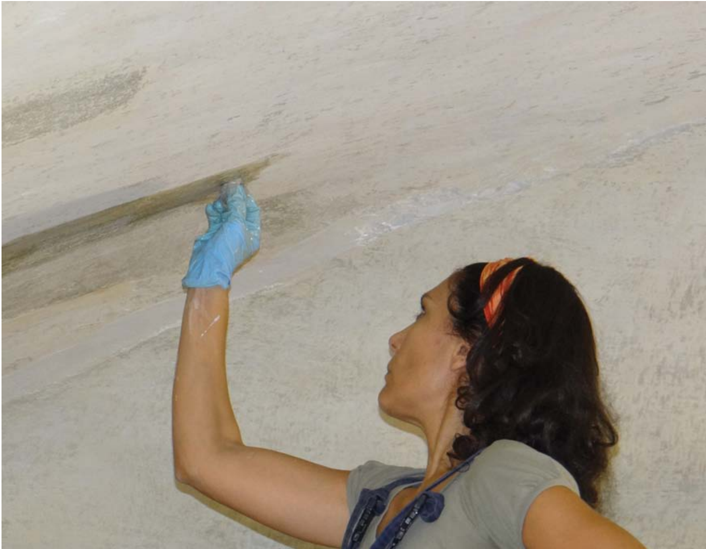
Intervento di rimozione strato di pittura a secco con bisturi
