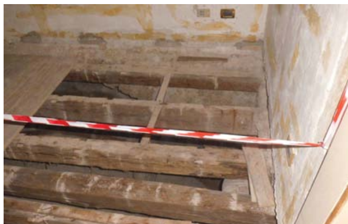
Sala Savoia - Solaio esistente
