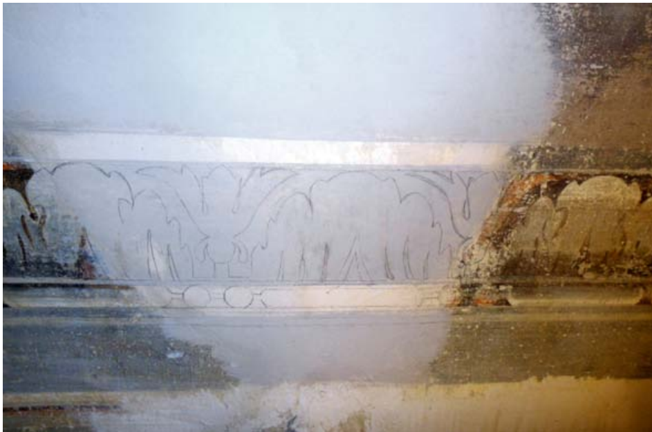
Ricostruzione parti mancanti
