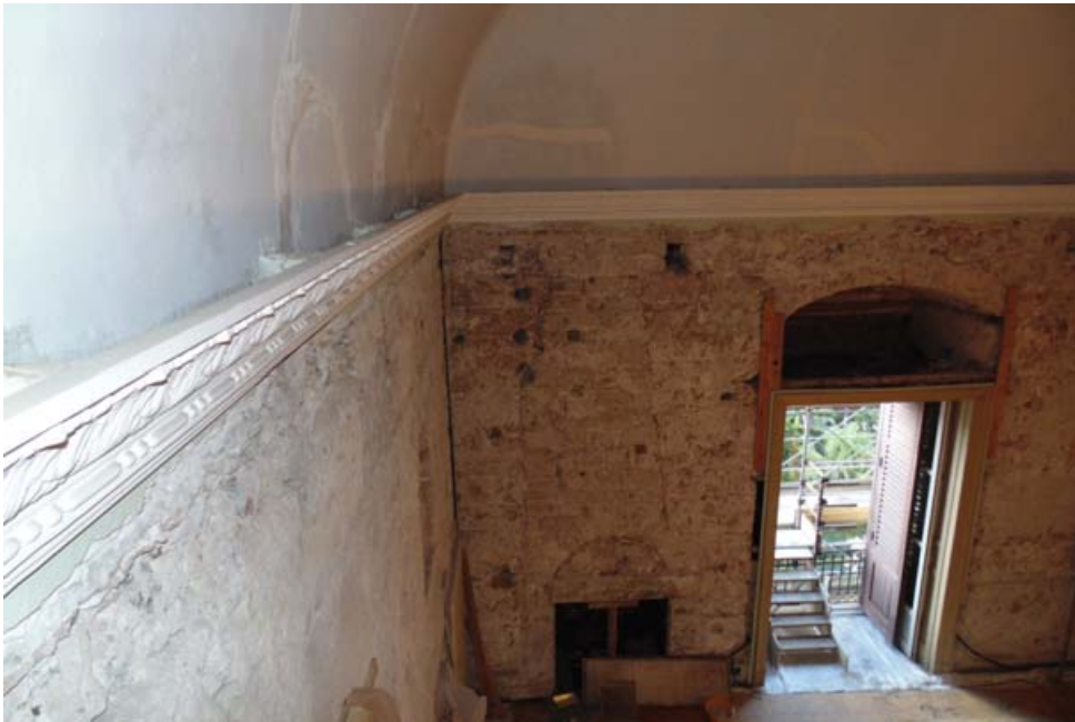
Particolare del cornicione prima del restauro
