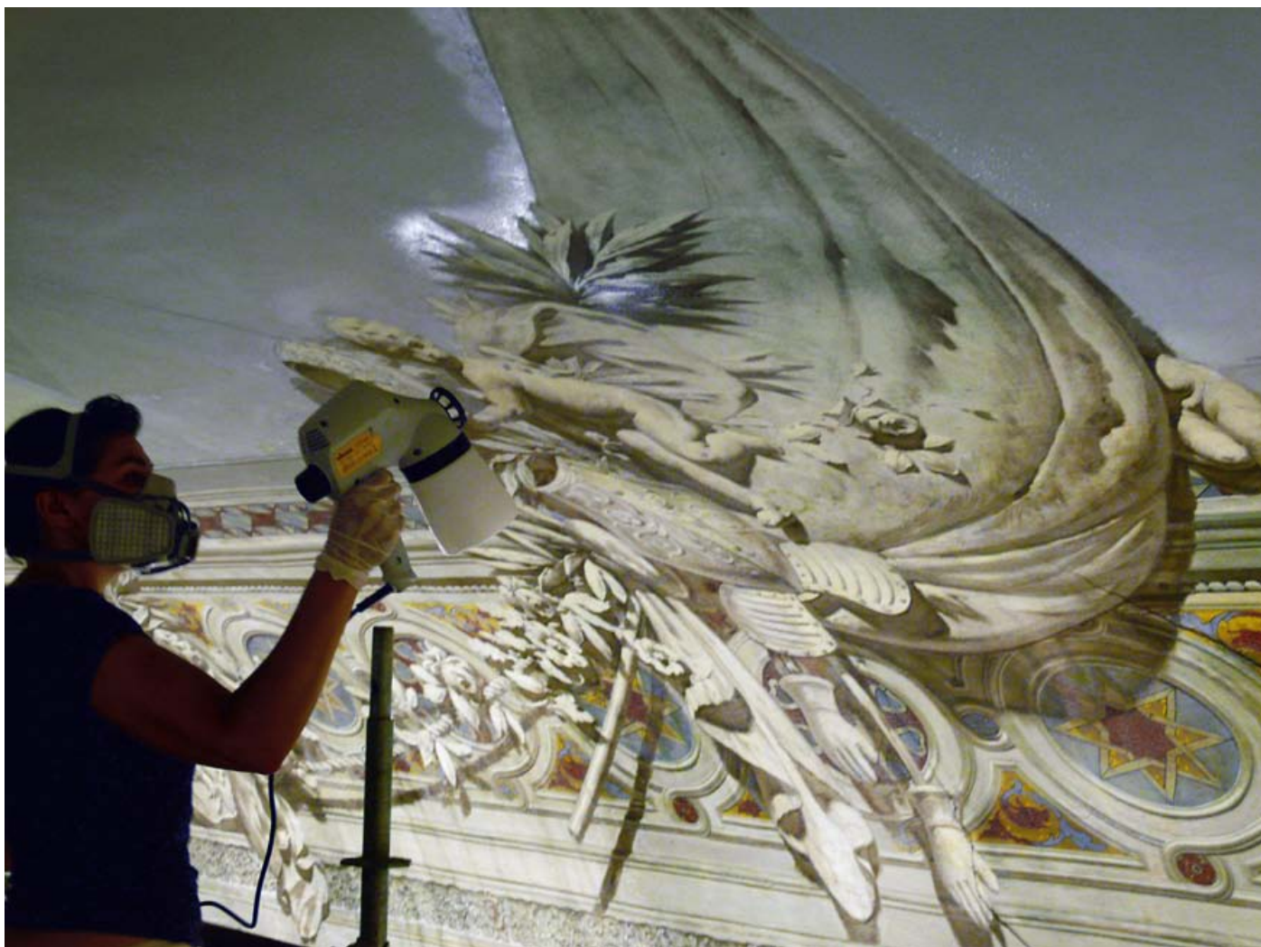
Particolare del preconsolidamento
