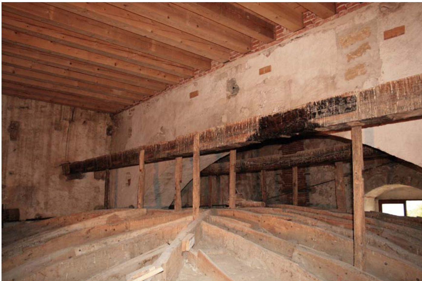
Particolare estradosso della volta incannucciata e dell'arco
