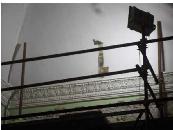
Particolare saggi di pulitura sulla volta
