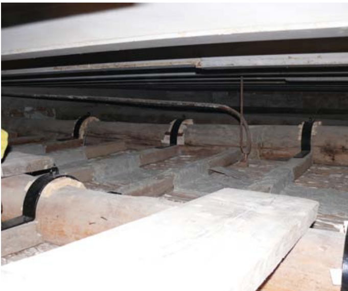
Particolare delle cuffie in acciaio inox e delle fasce in fibre di vetro
