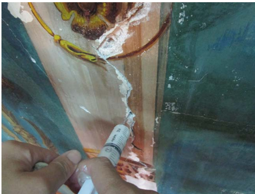
Consolidamento con micro iniezioni
