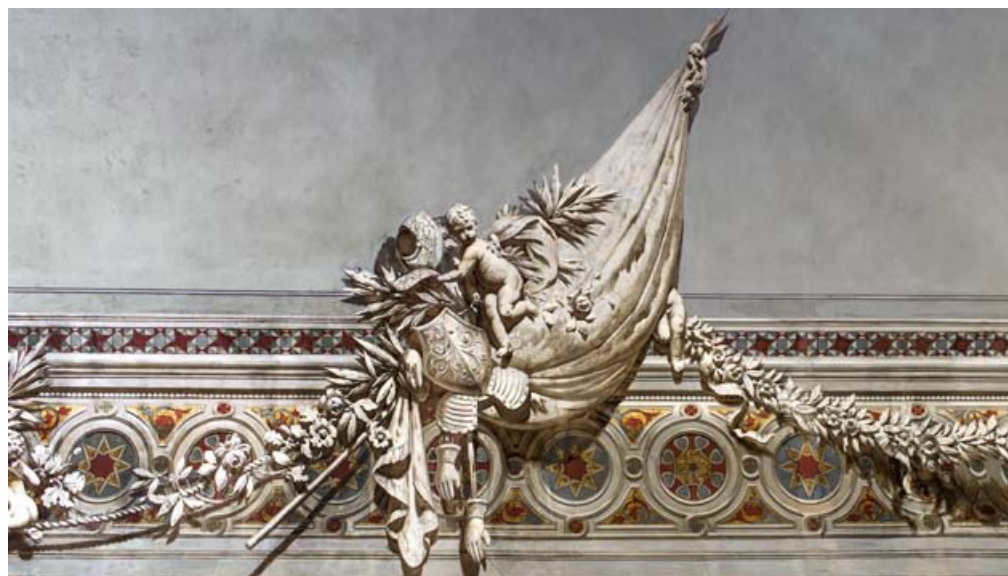
Particolare della volta dopo l'intervento di restauro
