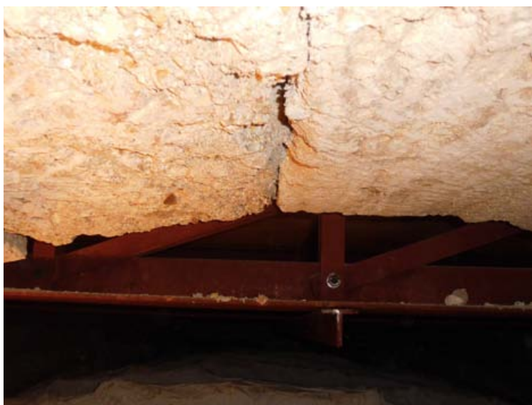
Sala Savoia - particolare dell'arco in pietra con la centina metallica
