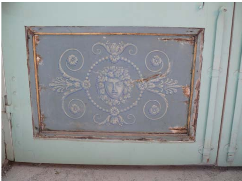
Particolare di una porta prima del restauro
