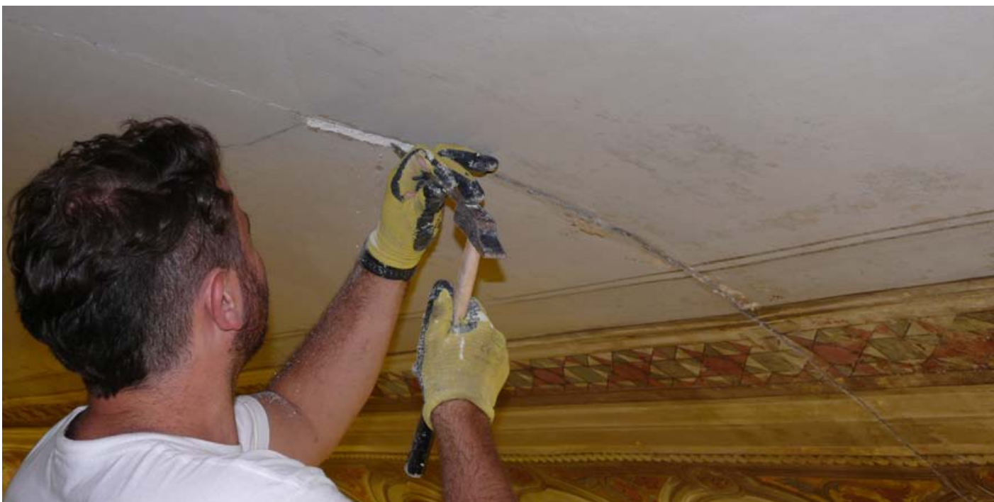
Rimozione delle vecchie stuccature
