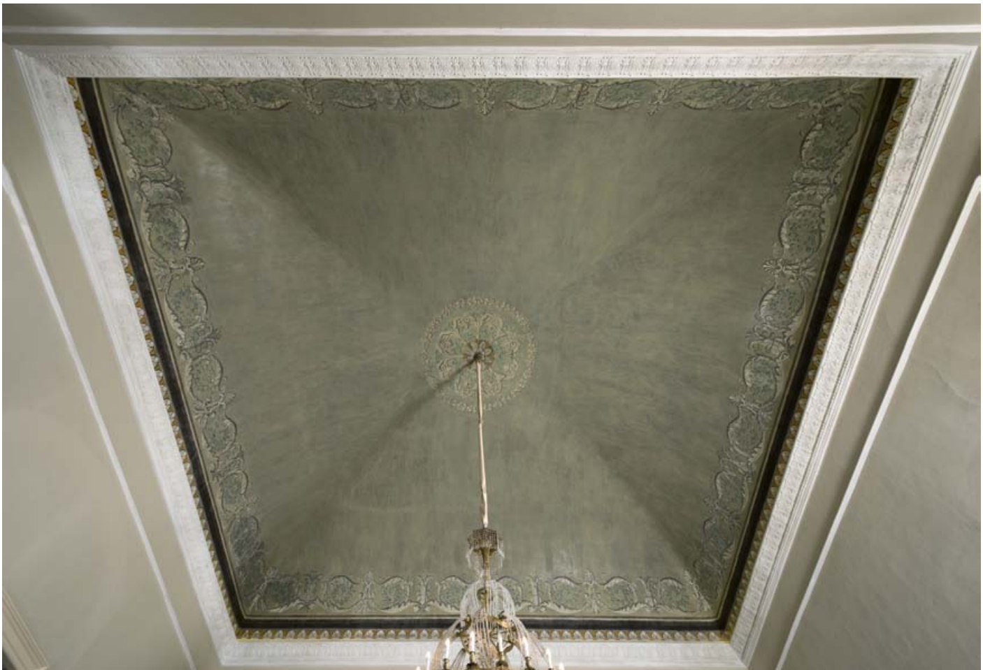
La volta dopo il restauro
