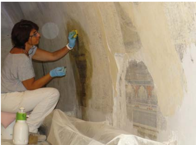
Rimozione strato gessoso con bisturi e spugne
