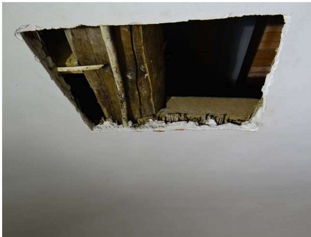
Particolare della finestra aperta nell'intradosso della volta
