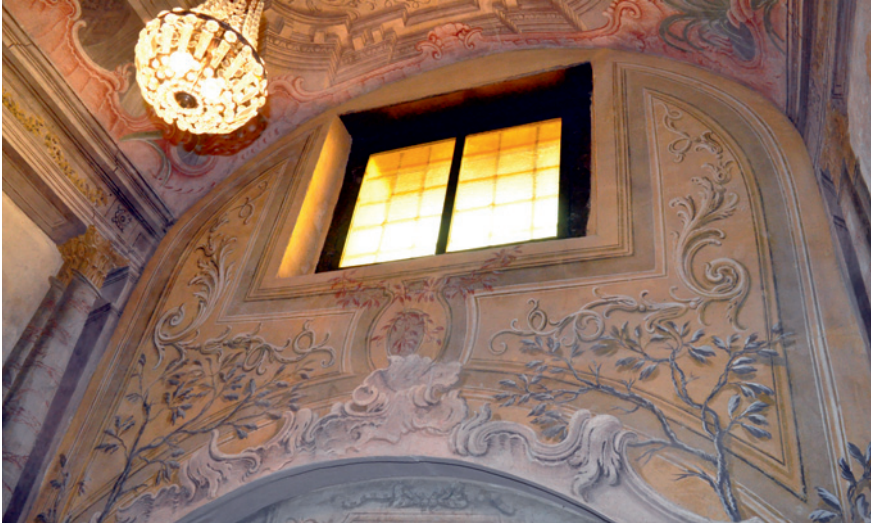
FIGURE 8 Western wall, upper fresco. PHOTO: GAETANO SCADUTI.
