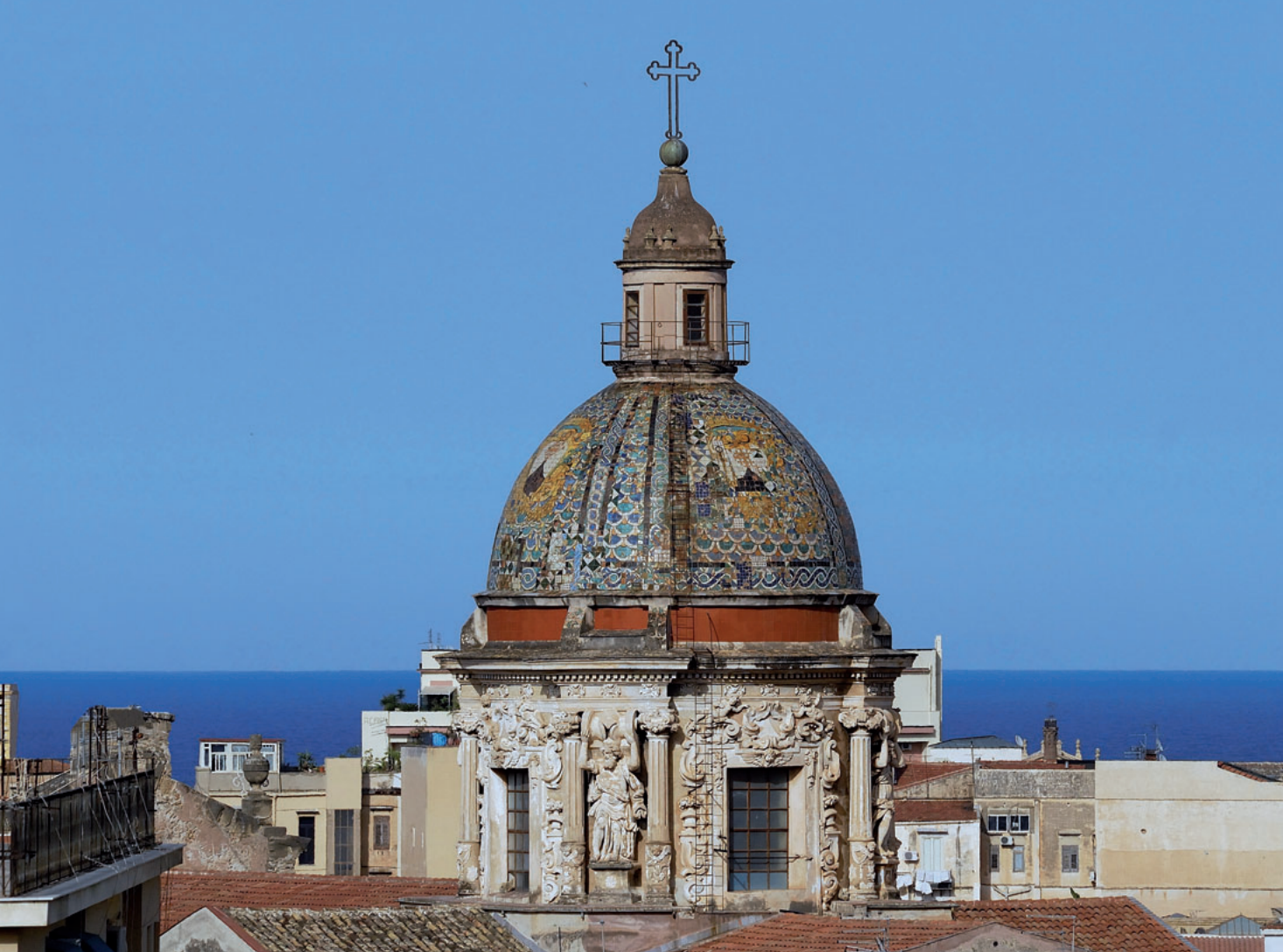
La cupola della chiesa di Santa Maria del Carmine (ph G. Palazzo).
