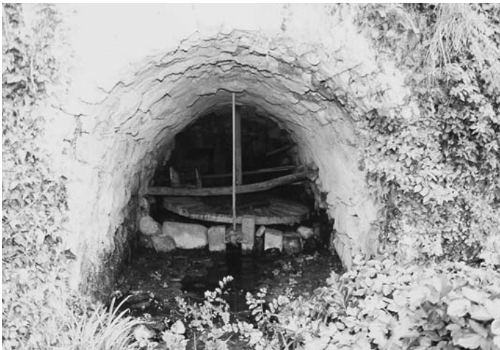
146. Il canale di deflusso, "casso" con la ruota idraulica.
