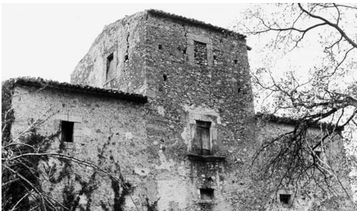
195. Particolare del prospetto principale.
