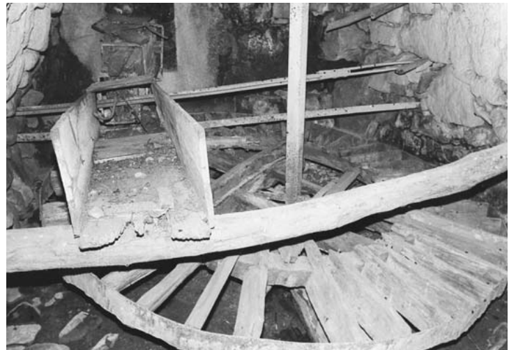
147. La ruota idraulica con la cassa per deviare il flusso dell'acqua.
