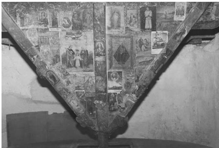
90. La tramoggia. Le immagini devote sono applicate con funzione apotropaica e propiziatoria.
