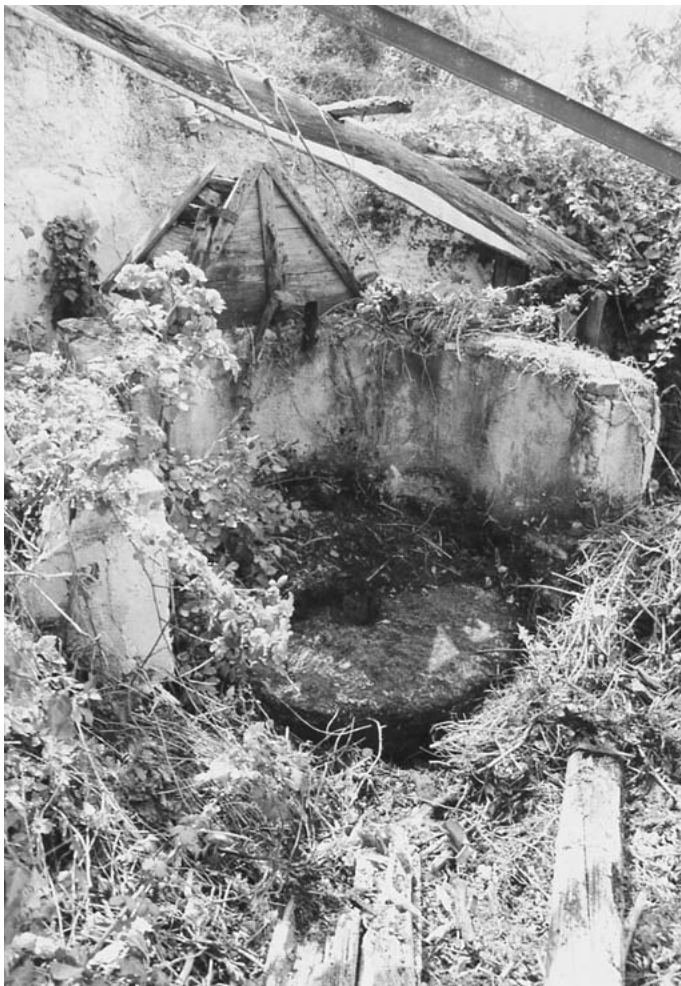
151. Apparato molitorio, sul muretto la tramoggia capovolta.
