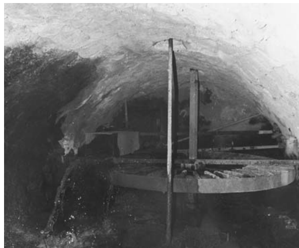
91. Il "casso" e la ruota idraulica metallica.
