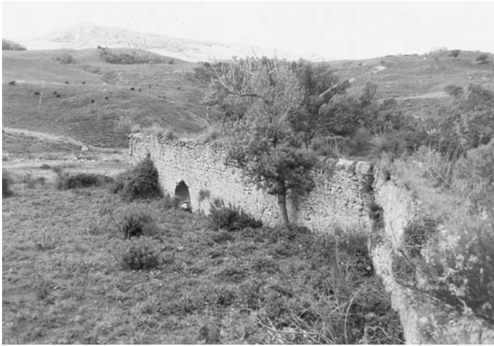
173. Prospetto laterale della canalizzazione.
