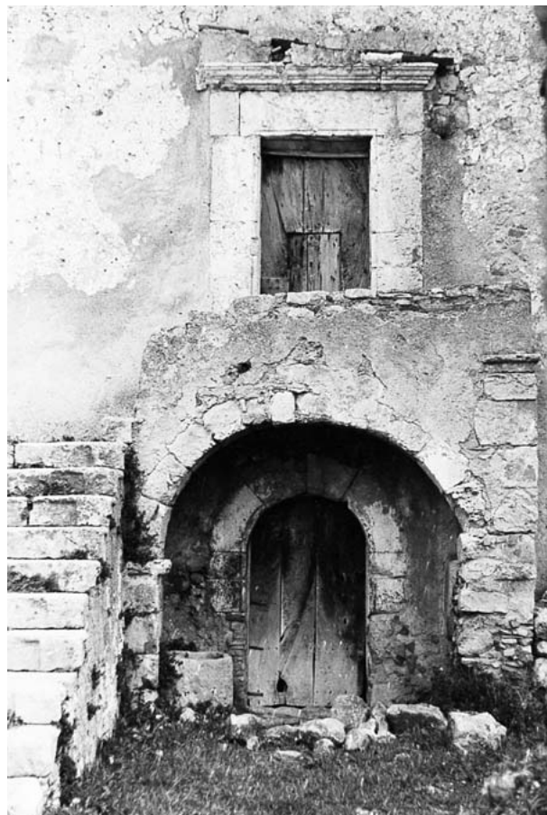
197. Particolare della scala d'ingresso.
