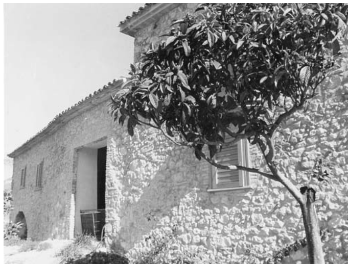
98. Prospetto laterale Sud.
