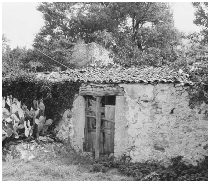
138. Prospetto principale con la gora.
