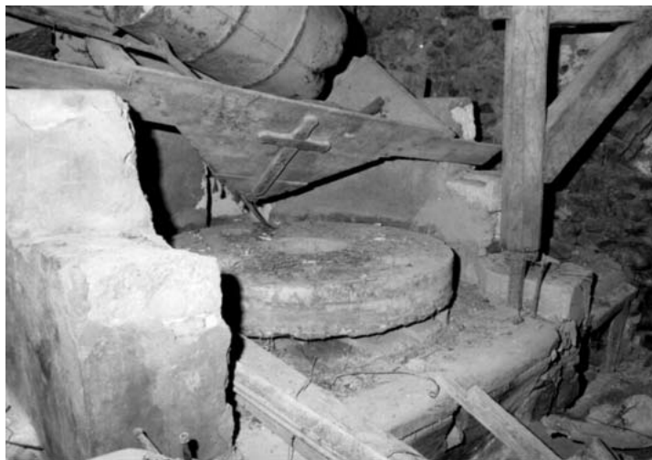
3. Castronovo, mulino San Pietro, particolare dell'apparato molitorio in stato di abbandono.
